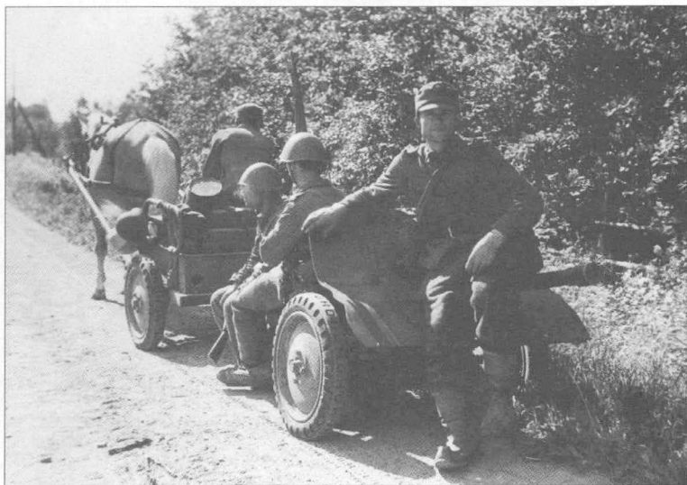
Ruotsalaisvalmisteinen 37 mm:n Bofors-panssarintorjuntakanuuna hevosvedossa etuvaunuineen jatkosodan aikana. Huom. ruotsalaisen tykin kaarevareunainen kilpi. SA-kuva 26294.
