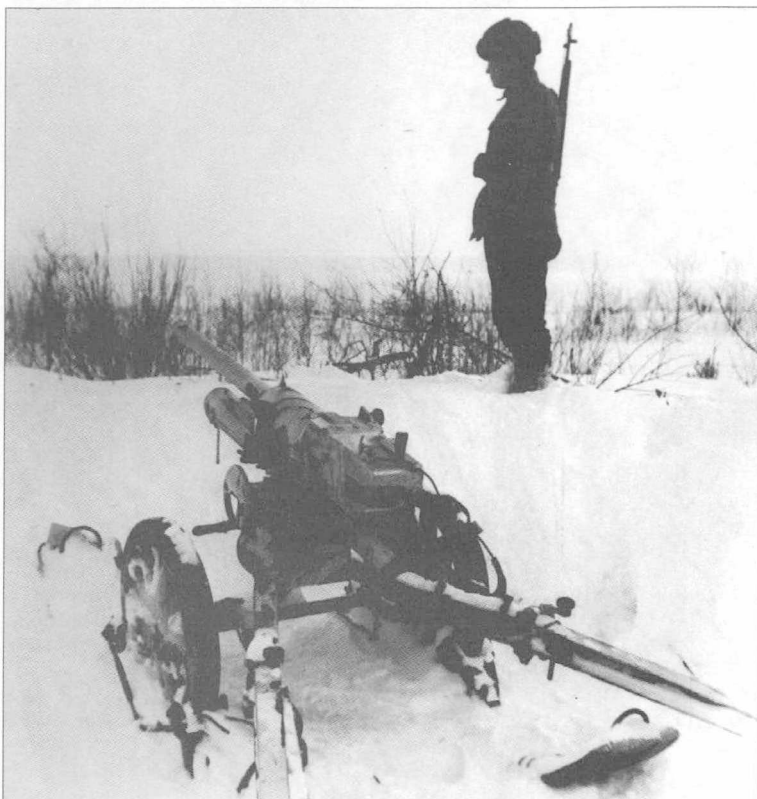
Italialainen 47 mm:n Böhler-tykki m/39 rannikkovarmistuksessa Taipaleenjoen suulla helmikuussa 1942. Tykkiin on kiinnitetty talvikuljetusta varten jalakset. SA-kuva 73662.
