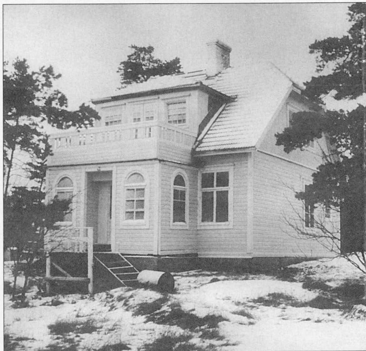
Bergudd-huvila Moisniemessä Espoon Soukanlahden rannalla. Huvila purettiin rajavartiolaitoksen uudisrakennuksen tieltä vuonna 1983. (Kuva: Suomenlahden merivartiosto)
