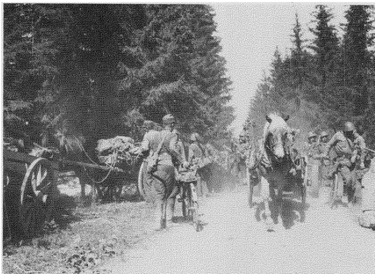
Huoltokolonnien aiheuttamaa ruuhkaa JR 36:n hyökkäyssuunnassa kulkeneella metsätieuralla. SA-kuva.
