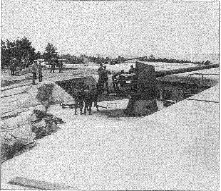
Rannikkotyökistön harjoitusammunta käynnissä Miessaarella vuonna 1921. Nelitykkinen 152/45 Canet-patteri oli ryhmitetty takaa avoimeen kasemattiin, mikä tarjosi suojaa vain laivatyökistön laakattulta vastaan. Linnakkeiden ilmatorjunnan tarve oli ilmeinen. Kuva: Sotamuseo.
