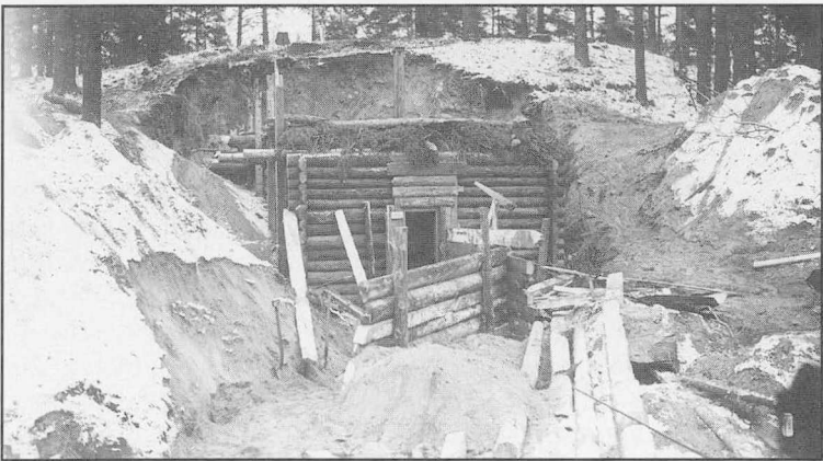
Rakennusvaiheessa oleva suojakorsu Lentolaiivue 10:n tukikohdassa Lappeenrannassa. Kuva on otettu 31.10.1939.
