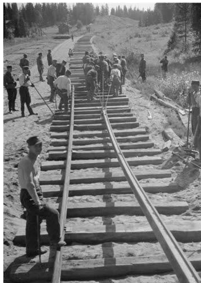
Rataa korjataan Sarjon aseman luona 1941
