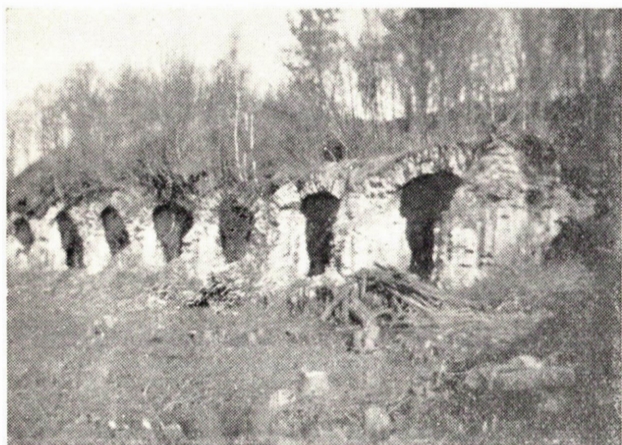
Kuva 6. Kyminlinnan linnoituksen lounaismuurin holvauksia. Vaults in the south-western walls of the Kyminlinna fortress.
