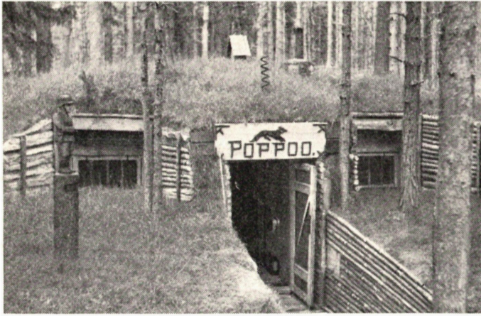
Kuva 6. Tasaiseen maastoon rakennettu korsu. Viihtyisyyden hyväksi on uhrattu paljon työtä, mutta korsun edessä räjähtävä ammus tekisi tuhoisaa jälkeä, koska ikkunat ovat suojattomat ja ovi aukeaa suoraan korsuun. Puhdetyökauden luomus nimikilpineen ja "totempaluineen".
