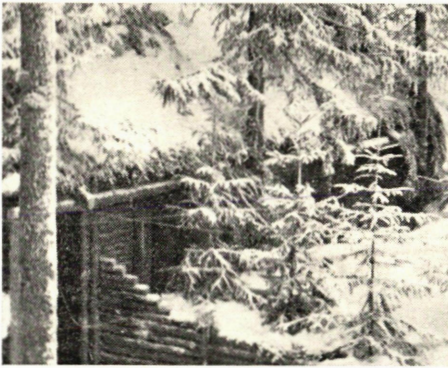
Kuva 5. Takarinteseen sijoitettu ikkunallinen korsu. Suojaisuus tyydyttävä.
