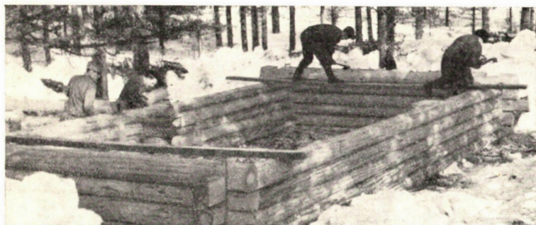
Kuva 1. Korsun kehikko veistetään lähiselustassa, josta se hevosilla kuljetetaan etulinjaan. Hirret numeroidaan, joten ne voidaan helposti latoa paikoilleen.
