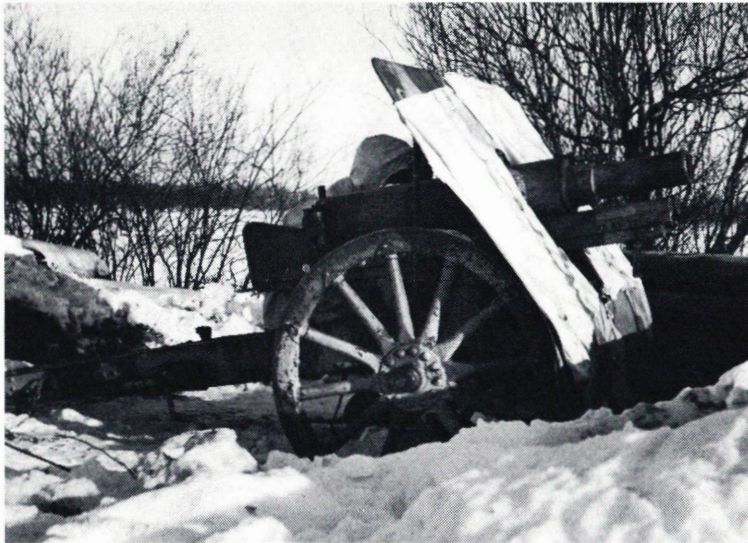
76LK/13. Venäläistä valmistetta. Soveltui hyvin korpisodan olosuhteisiin. Paino tuliasemassa 0,8 tonnia, kantama 7 km. Oli käytössä vain Talvisodassa ja jatkosodan alkuvaiheessa.
