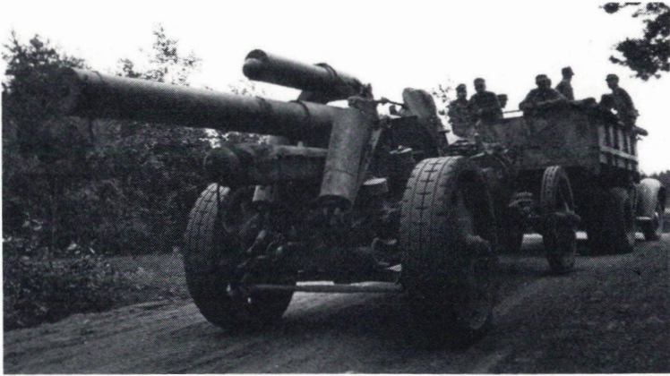
150H/40. Jatkosodan alkuvuosien yleisin raskas haupitsi. Saksa-laista valmistetta. Paino tuliasemassa 5,2 tonnia. Kantama 13,3 km.
