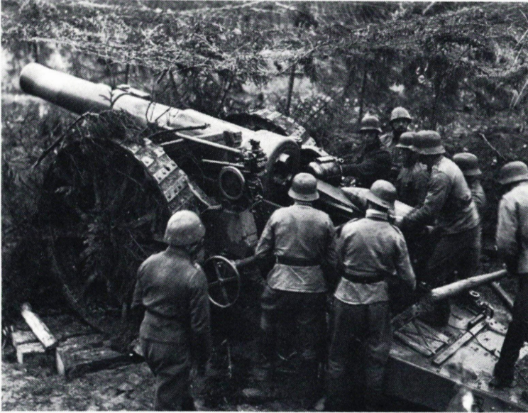
203H/17. Yleisin järeä haupitsi. Amerikkalaista valmistetta. Paino tuliasesmassa 8,7 tonnia, kantama 9,5 km.
